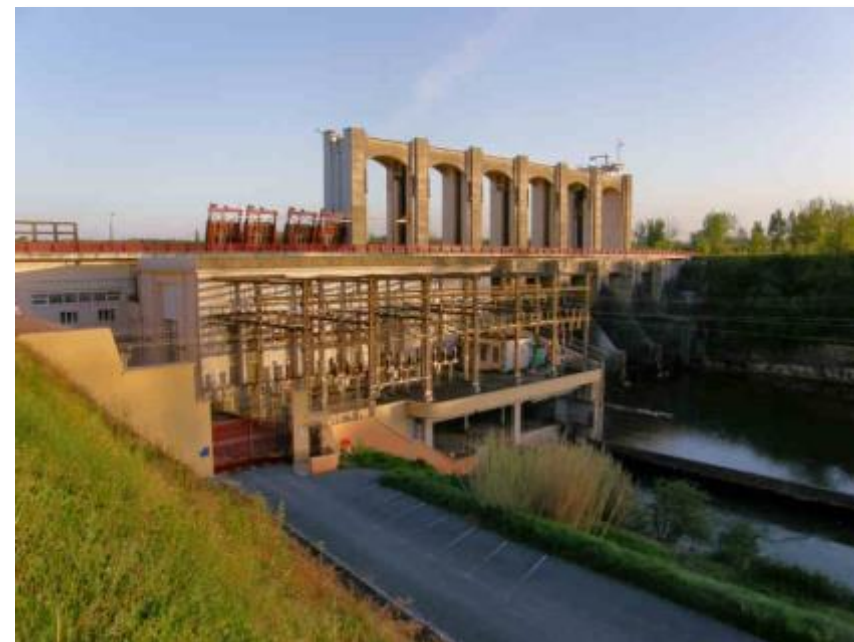
Vue du Barrage de Rivières
