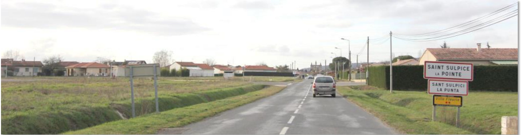
Entrée de ville N°9 : le panneau d'agglomération est bien placé en limite de secteur urbain continu renforçant ainsi la coulée verte qui valorise le front urbain en constitution. La vue lointaine sur le clocher de l'église Notre Dame de Saint-Sulpice apporte beaucoup de caractère à cette entrée Est
