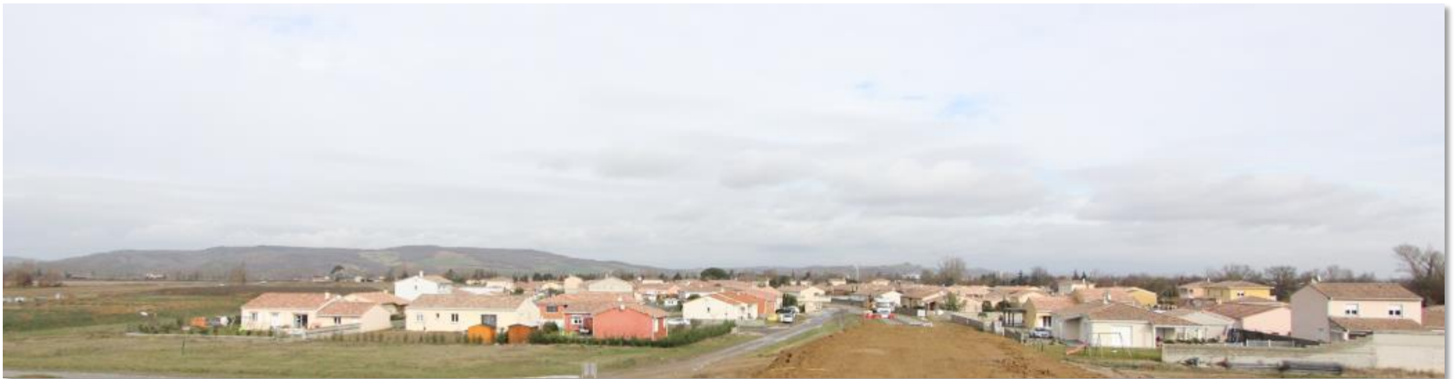
Photo prise du chantier du nouvel échangeur qui permettra un accès direct au Parc d'Activités des Portes du Tarn. Le lotissement visible est très récent et se situe à proximité directe de l'échangeur et de l'A68. Pourtant, les premières habitations se trouvent dans la zone de retrait pour éviter les nuisances sonores. Le relief des coteaux de Montclar demeure un important point de repère dans le paysage.
