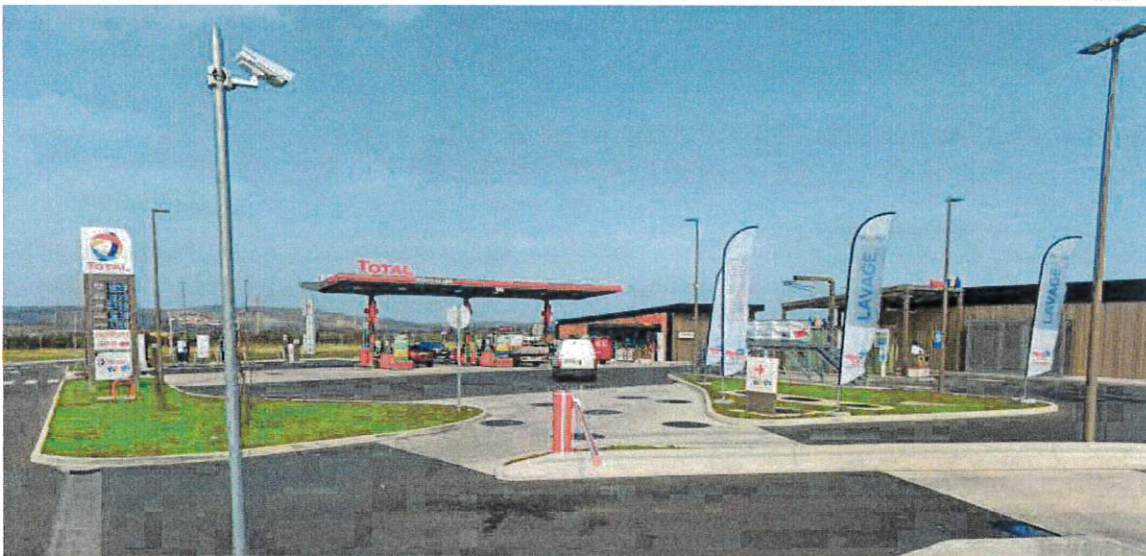
Photo 70 : Enseignes scellées au sol, posées au sol et sur toiture, aire des Portes du Tarn - StreetView
