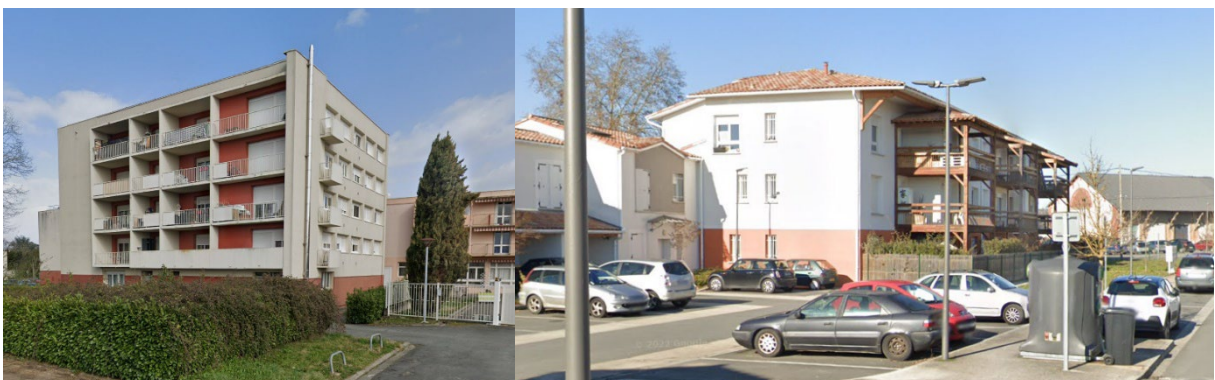
Photo 6 : A gauche, ilot d'habitats collectifs des années 70 le long de l'avenue A. Camus. A droite, nouvelle opération de logements à proximité de la gare. – StreetView.
