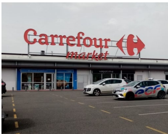
Photo 21 : Enseigne sur toiture sur la zone commerciale des Terres Noires – EVEN Conseil
