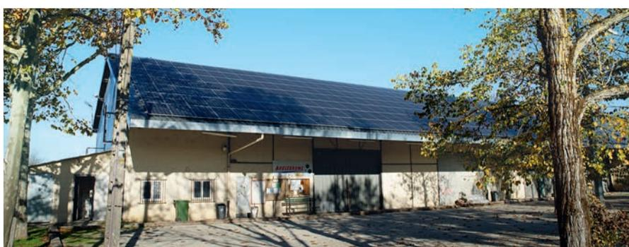
À l'issue de travaux menés cet été, la toiture vieillissante du bâtiment abritant le tennis couvert et le boulodrome historique a été remplacée, par une toiture neuve intégrant des panneaux photovoltaïques.
