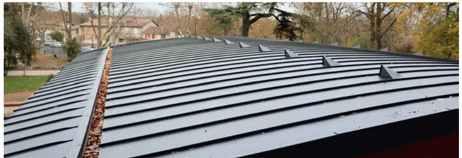
cause, des pointes remontantes qui sous l'effet de la dilatation, ressortaient des charpentes et ont percé le revêtement en zinc. Pour solutionner durablement ce problème, d'importants travaux de réfection ont été réalisés du 14 septembre au 30 octobre 2020, pour un coût de 68 000 €.
