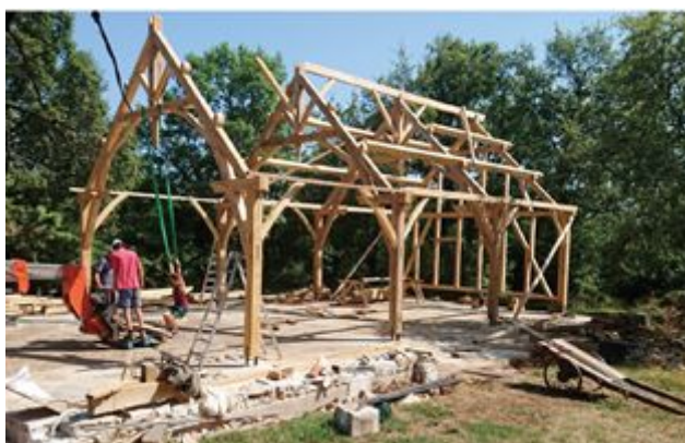
Chantier de la Halle en charpente traditionnelle - La Cayrouse, Aveyron
